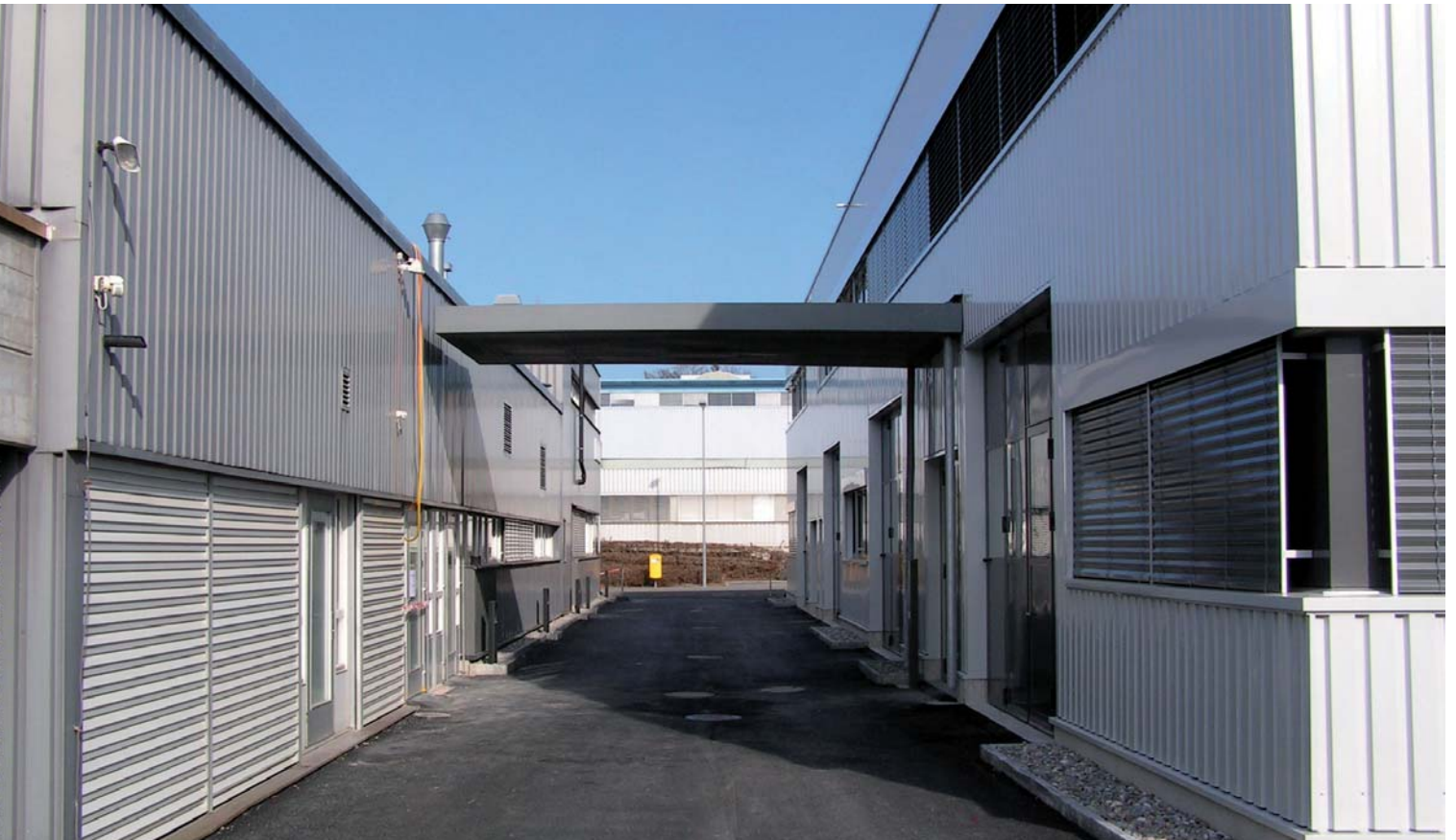
Sowohl der Altbau (links) als auch der Erweiterungsbau (rechts) werden mit Erdgas beheizt.
